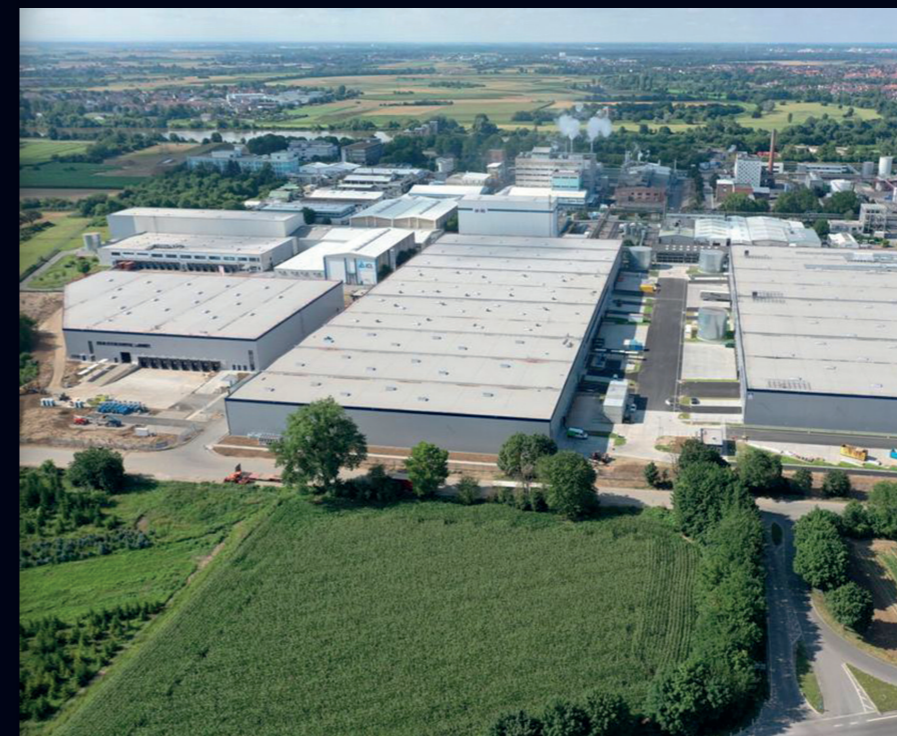
Das neue Logistikzentrum von neska zur Lagerung von Gefahrenstoffen
